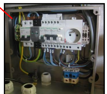
Bornier d'alimentation (X1) Coffret de distribution général
